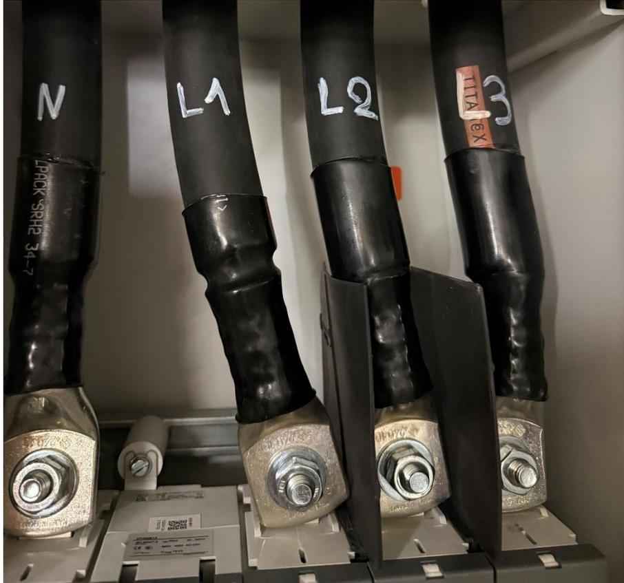
En cas d'utilisation d'un **câble souple** de type HN07..., il convient d'employer des cosses ou des embouts de câblages adaptés afin d'assurer une connexion fiable.
