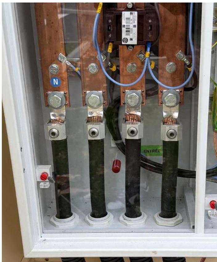
Le câble provenant du CCPI doit être raccordé dans les **cages de raccordement** prévues à cet effet.
