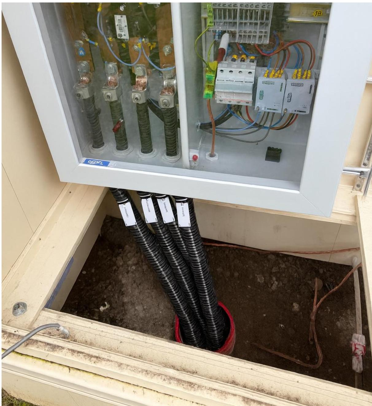
Un **fourreau TPC**, rouge ou noir avec liseré rouge, d'un diamètre minimum de 110 mm, devra être installé pour la liaison en provenance du CCPI.
