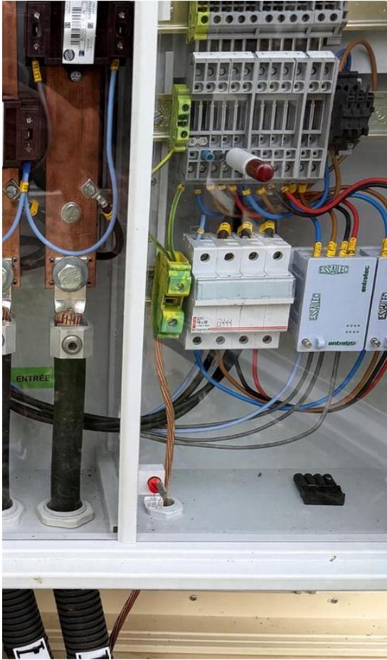
L'armoire doit être mise à la terre à l'aide d'un conducteur de protection de **section 25 mm<sup>2</sup>**.
