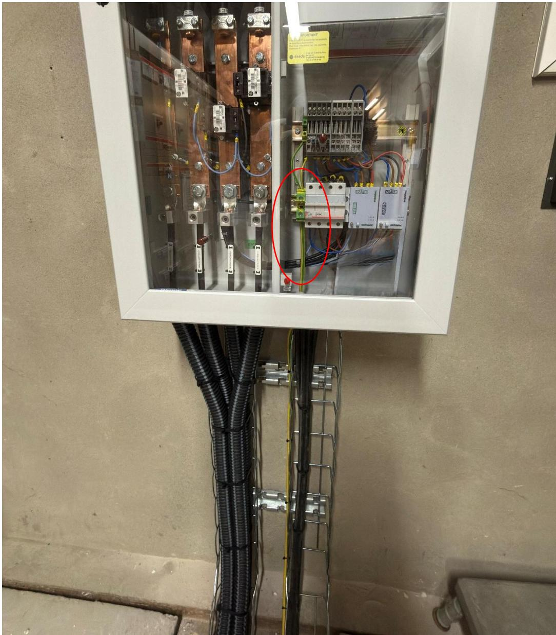
L'armoire doit être mise à la terre à l'aide d'un conducteur de protection de **section 25 mm<sup>2</sup>**.
