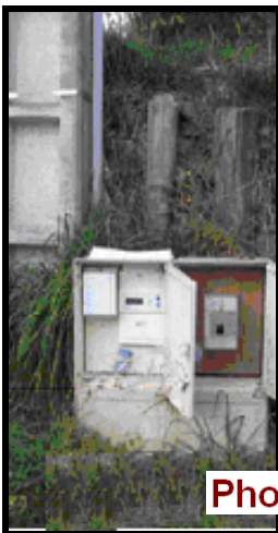
Compteur et disjoncteur dans coffrets extérieurs (généralement dos à dos)
