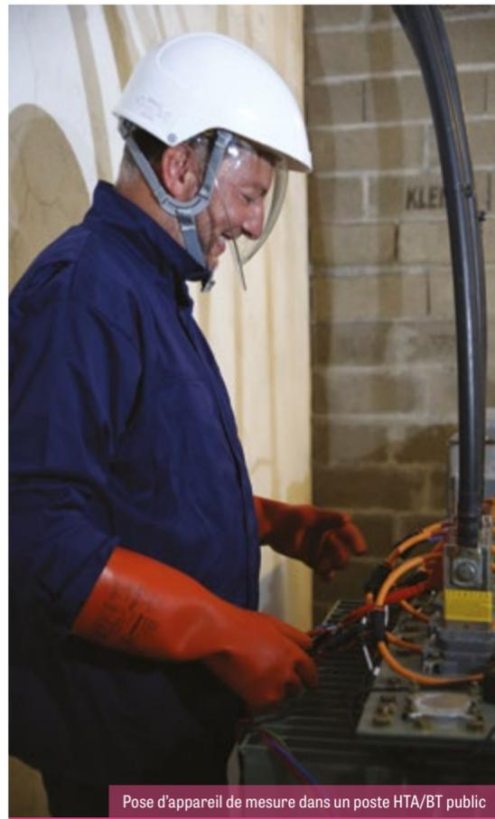
Pose d'appareil de mesure dans un poste HTA/BT public
